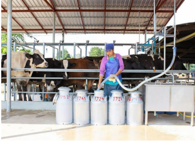
ภาพที่ 4 ระบบ Pipe Line Cooling Tank ฟาร์มโคนม
